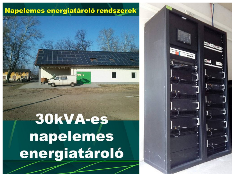
4.ábra: 30 kVA-es napelemes szünetmentes áramellátó rendszer
